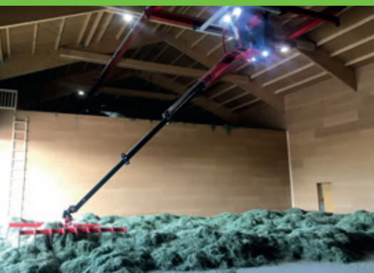
Am Standort „Hof Kuhsattel“ liegen Offenlaufstall, Weideland und die neue Heutrocknungsanlage.
