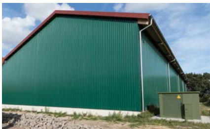
Stattlich: Die neue, luftdicht ausgelegte Halle von Icken ist 60 x 20 m groß und 10 m hoch.
