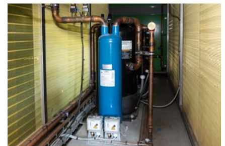
Links vom Kompressor sitzt der Tauscher zum Kühlen, rechts der zum Anwärmen der Luft.
